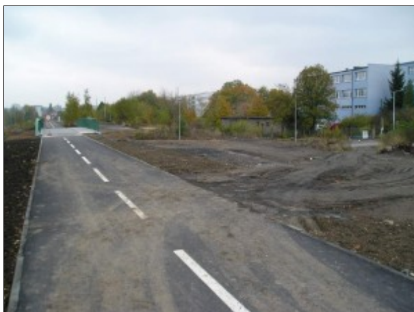
Obr. 3: Stávající podoba odbočení do ulice U Elektry
